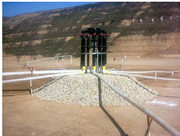
天津双口填埋气发电厂-集气站 Gas collection station
